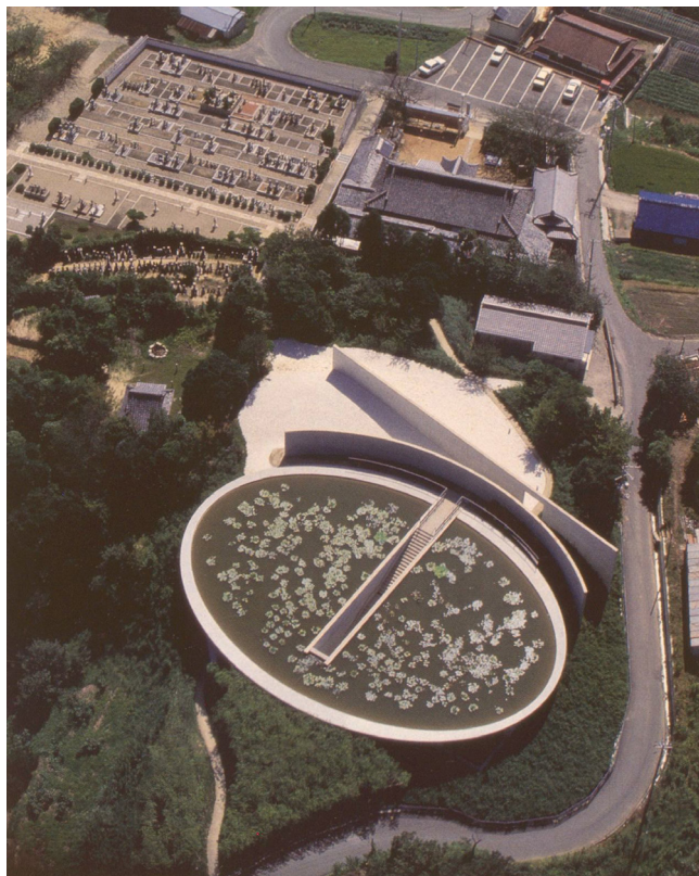
Abbildung 167: # 254 Honpukuji 本福寺 Gesamtansicht (Awaji, 1991, Shingonshū), © Ando Tadao & Matsuoka Mitsuo.
