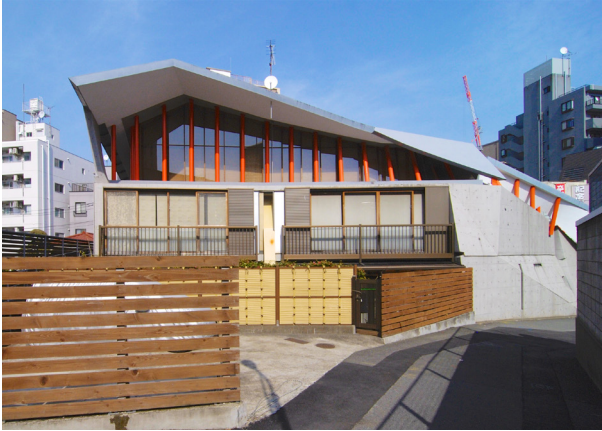
Abbildung 172: # 393 Kannonji 観音寺 gesamte Anlage (Tōkyō Shinjuku, 1996, Shingonshū), © Jonas Gerlach.
