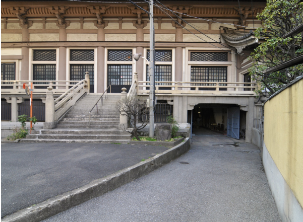
Abbildung 244: # 216c [Nr. 1] Higashi-Honganji Tōkyō betsuin 東本願寺東京別院 Parkplatz unter der Haupthalle (Tōkyō Taitō, 1953, Jōdoshinshū), © Jonas Gerlach.
