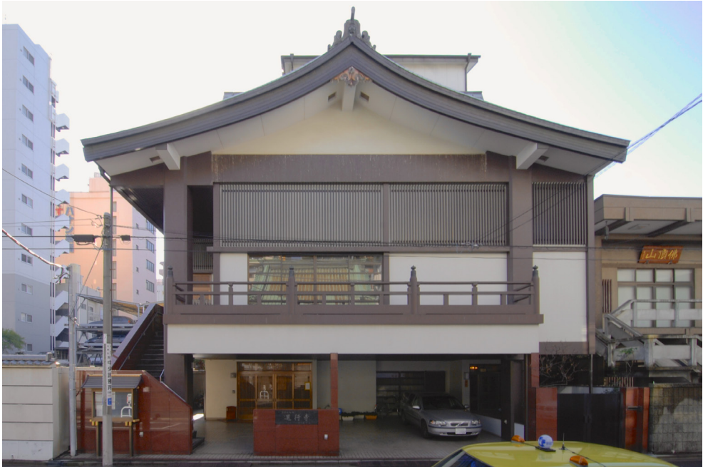
Abbildung 4: # 827a [Nr. 14] Unkōji 運行寺 Haupthalle (Tōkyō Taitō, Baujahr unbekannt, Jōdoshinshū), © Jonas Gerlach.
