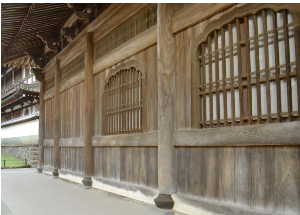
Abbildung 139: Kenchōji 建長寺 kato mado 花頭窓 an der Dharma-Halle ( hattō 法堂) (Kamakura, Edo-Zeit, Rinzaishū), © Jonas Gerlach.
