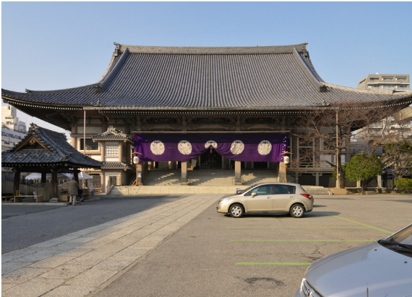
Abbildung 69: # 216b Higashi-Honganji Tōkyō betsuin 東本願寺東京別院 Haupthalle (Tōkyō Taitō, 1953, Jōdoshinshū), © Jonas Gerlach.
