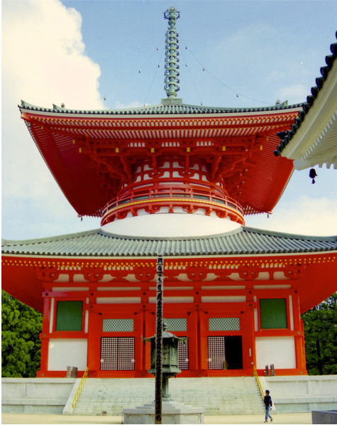
Abbildung 63: # 450b Kongōbuji 金剛峯寺 Konpon daitō 根本大塔 (Ito, 1937, Shingonshū), Foto gemeinfrei.
