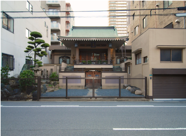
Abbildung 255: # 471b Kōshōji 光照寺 Tordurchfahrt (Ōsaka, Baujahr unbekannt, Jōdoshinshū), © Jonas Gerlach.
